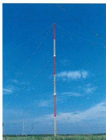
▲短波回線モニター用対数周期アンテナ Log-Periodic Antenna for Monitoring HF Circuits
