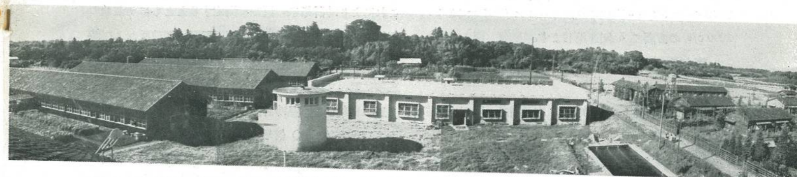
写真 19 電波研究所小金井庁舎機械室
