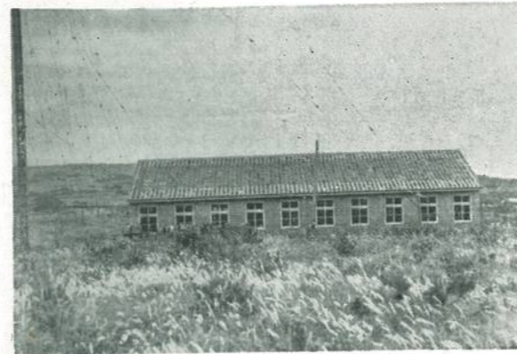
写真40 犬吠電波観測所
