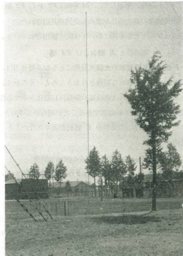
写真3 移動用電界強度測定空中線 (高さ20米)
