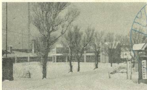
稚内電波観測所 北海道稚内市緑町3の37 電 稚内 3386 Lat. 45° 24' N Long. 141° 41' E
