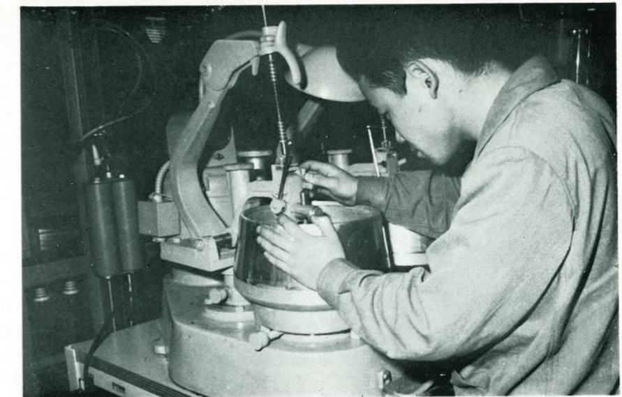
水晶振動子球面研磨装置
