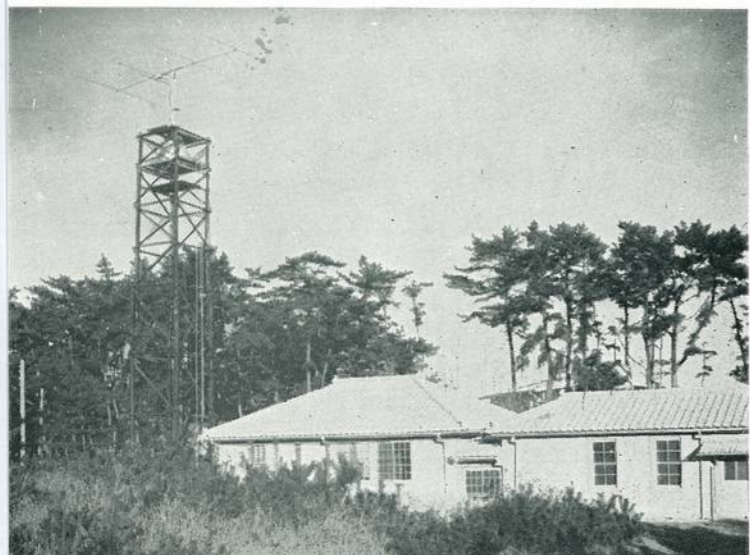
写真 6. 大洗分室における後方散乱波測定用回転八木空中線
