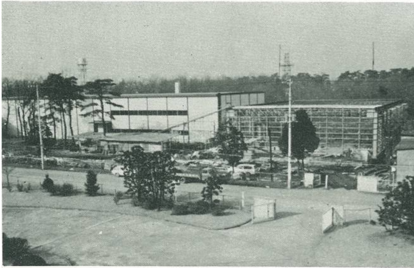
建設中の衛星試験庁舎
