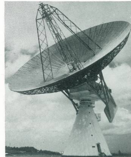
30mアンテナ完成
